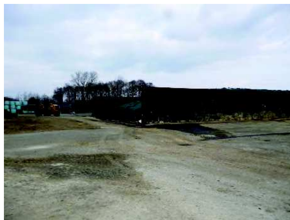
Abb. 23 Vorhandene Silagelagerflächen mit der Verbindung zum Betriebsgelände der BGA
