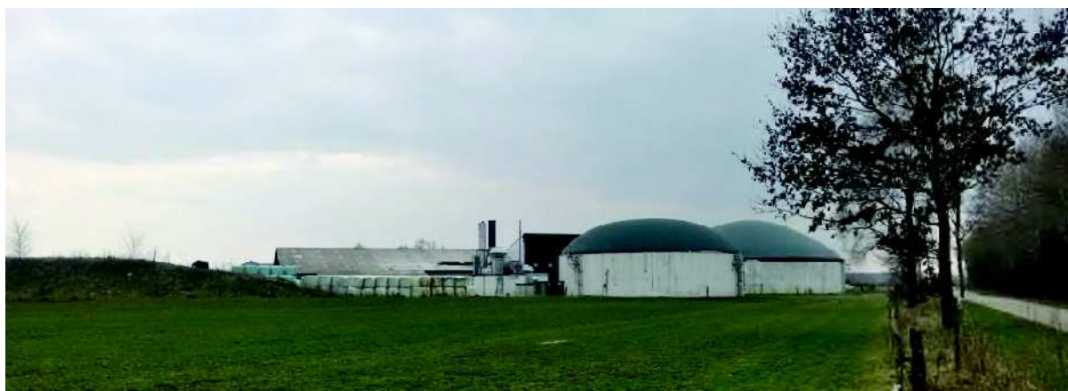
Abb. 6: Blick vom Gemeindeweg „Sofell“ aus nach Westen auf die bestehende Biogasanlage am Standort „Rosenhof“
