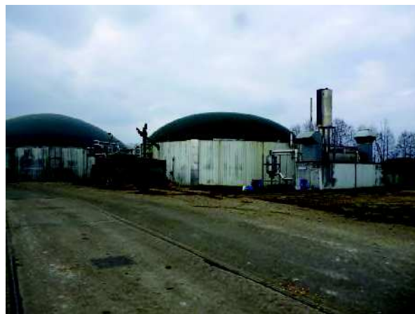
Abb. 34 Blick aus östlicher Richtung vom Betriebsgelände der BGA auf den vorhandenen Nachgärer (links), den Fermenter (Mitte) und das Blockheizkraftwerk
