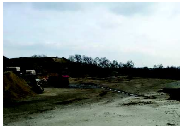
Abb. 16 Silagelagerflächen mit vorgelagerten Betriebsflächen; im Hintergrund der Gehölzsaum an der „Heischbek“
