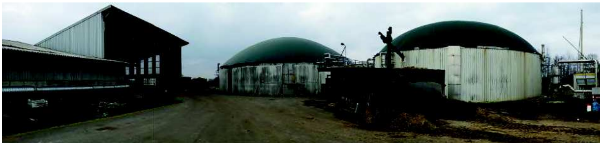
Abb. 8 Panoramabild der Biogasanlage mit dem Gärrestelager (mittig) und dem Fermenter mit dem Feststoffdosierer (rechts) und Lagerhalle (links), die dem landwirtschaftlichen Betrieb Rosenhof zugeordnet ist.
