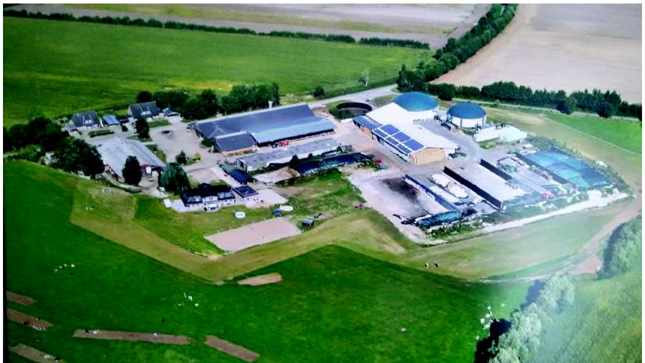
Abb. 1 Blick auf den landwirtschaftlichen Betrieb „Rosenhof“ mit der vorhandenen Biogasanlage und den Silageflächen rechts oben im Bild
