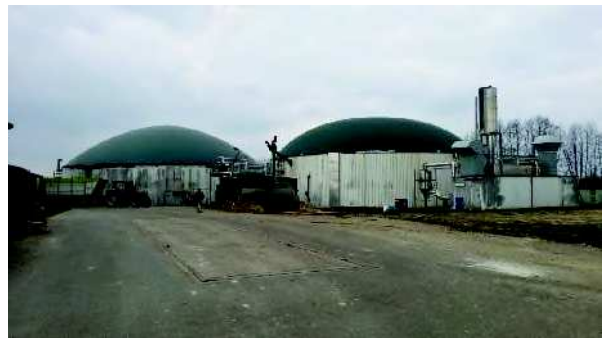
Abb. 10 Blick vom Betriebsgelände über die Fahrzeugwaage auf den Fermenter (rechts), den Nachgärer (links) und den BHKW-Container der bestehenden Anlage
