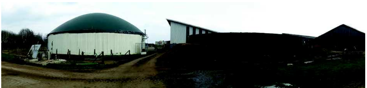
Abb. 7 Panoramabild des Zufahrtbereichs - während der grauwandige Rundbehälter links im Vorhabengebiet liegt, gehört der grüne dachlose Rundbehälter rechts nicht zum Vorhabengebiet, sondern wird dem angrenzenden landwirtschaftlichen Betrieb zugeordnet.
